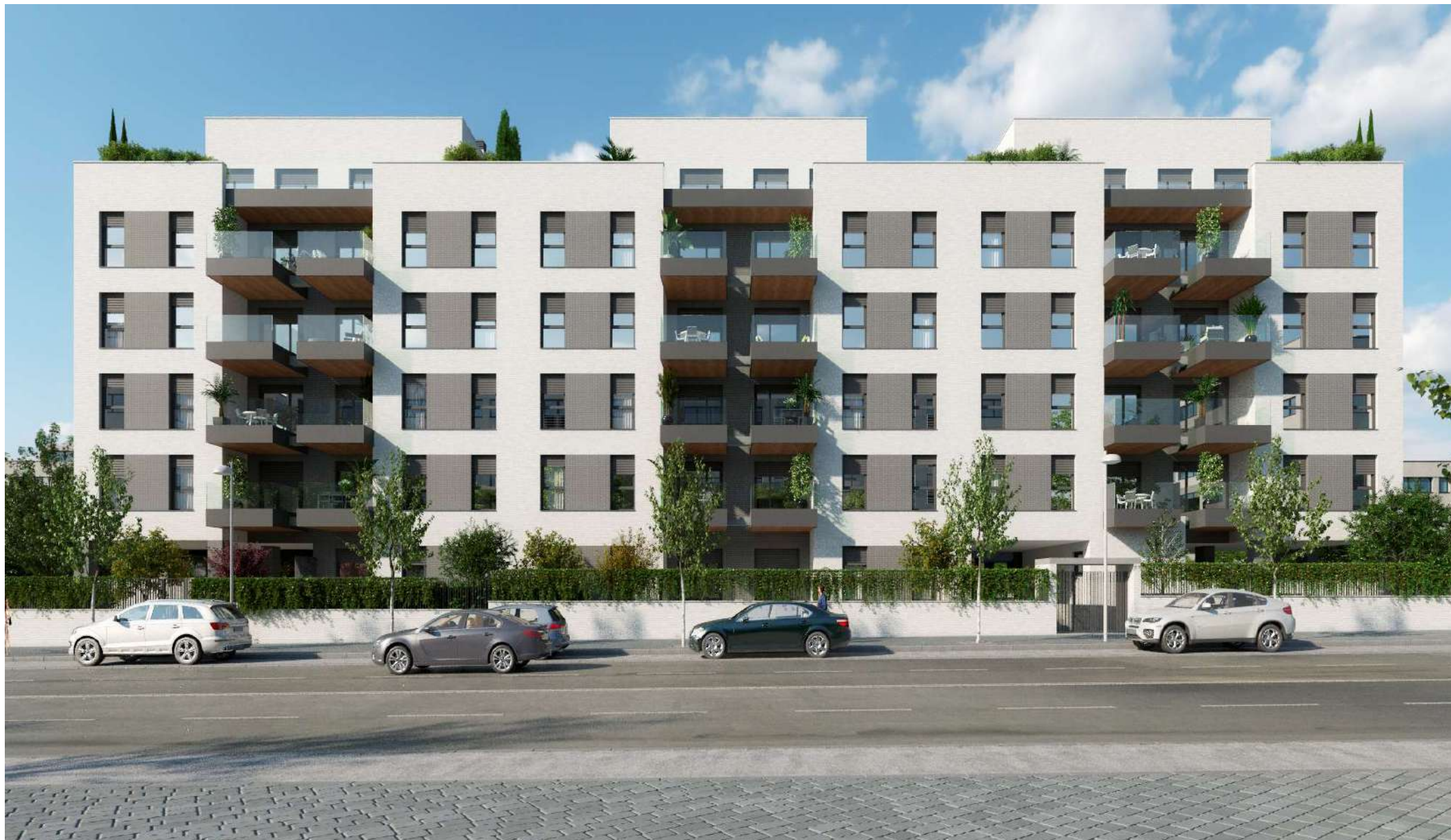
FACHADA EXTERIOR ESTE (Vía Pública)
