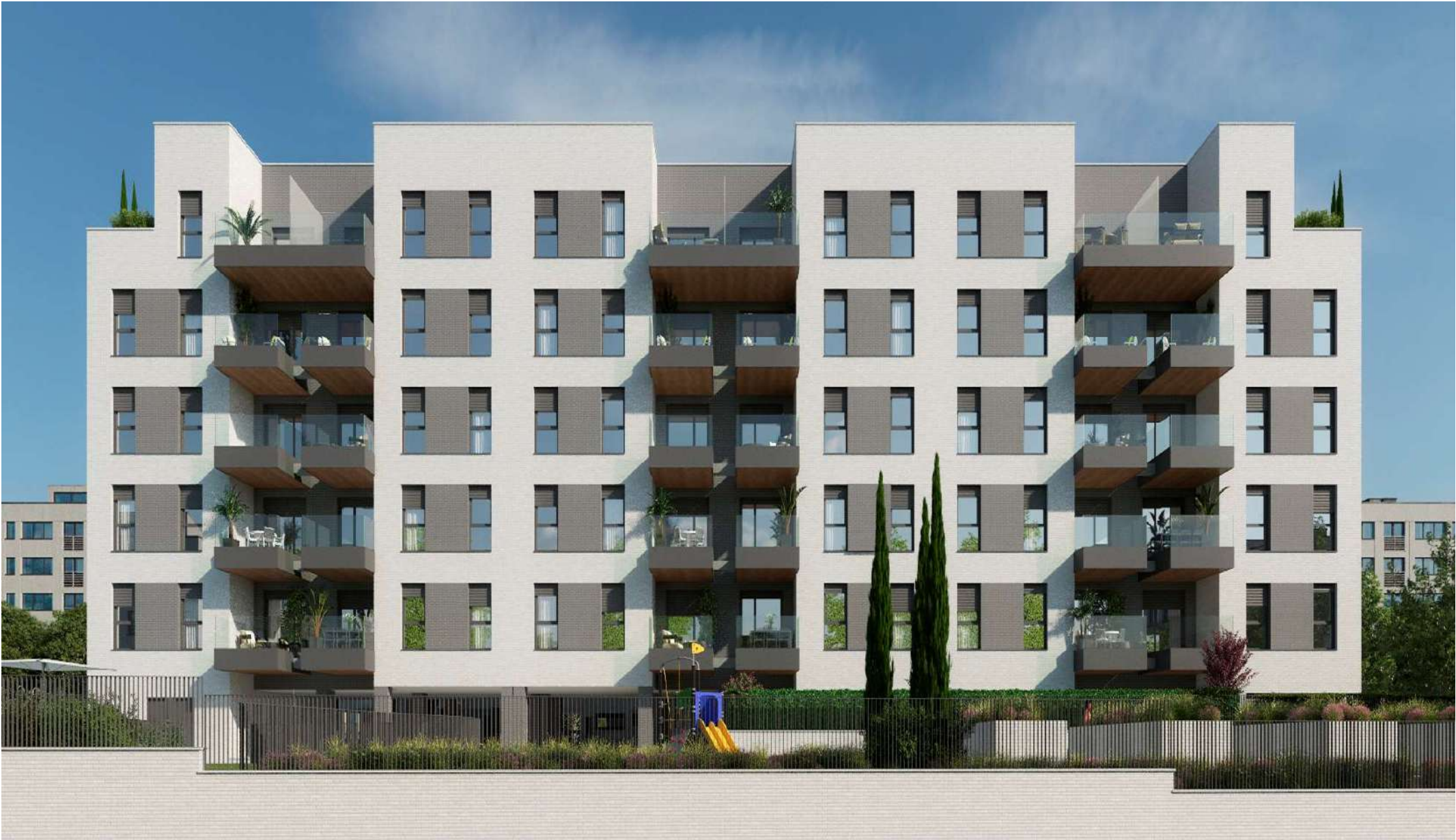
FACHADA EXTERIOR OESTE (Zonas Comunes)
