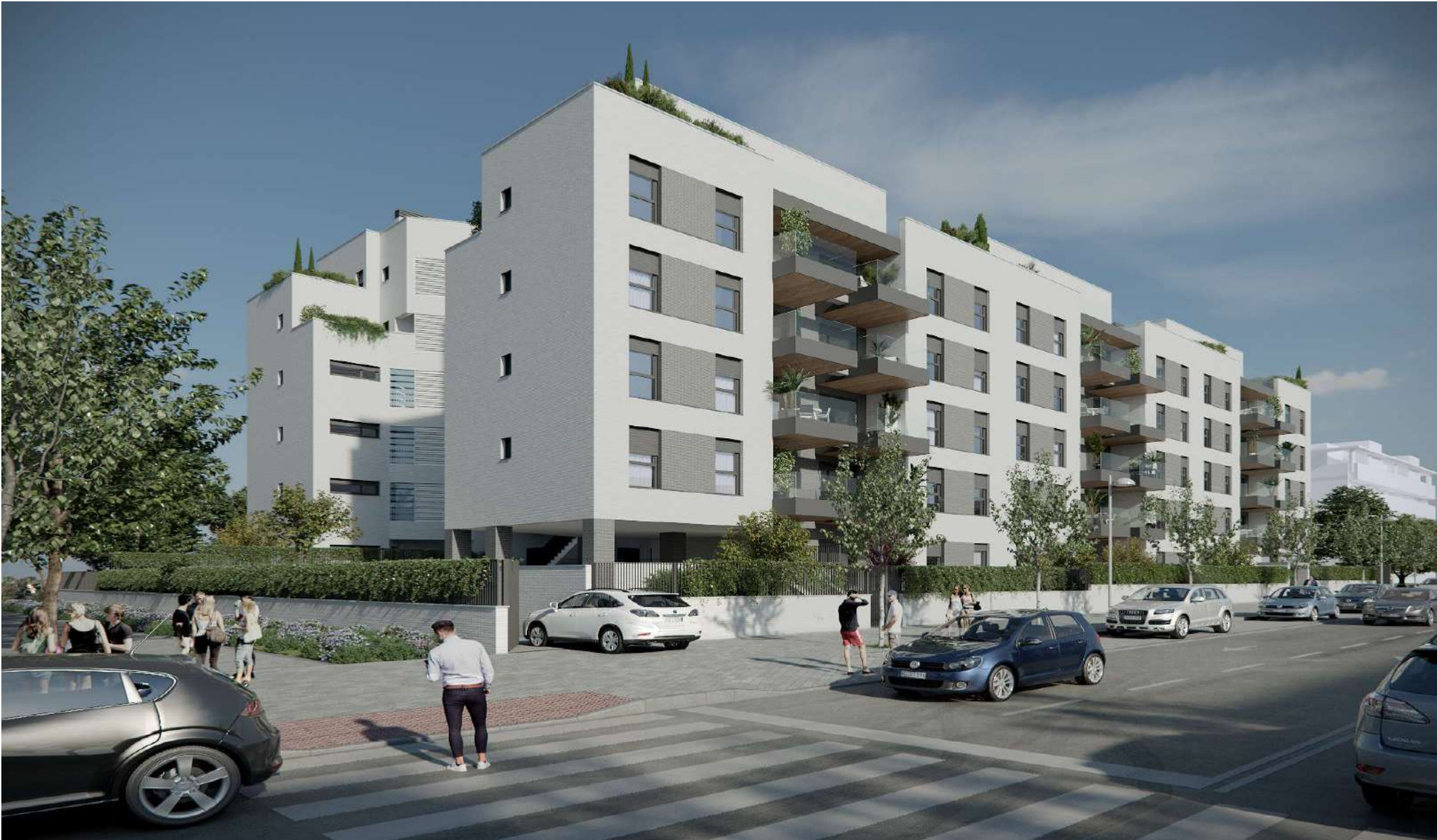
FACHADA EXTERIOR SURESTE (Entrada Vehículos-Garaje Subterráneo)
