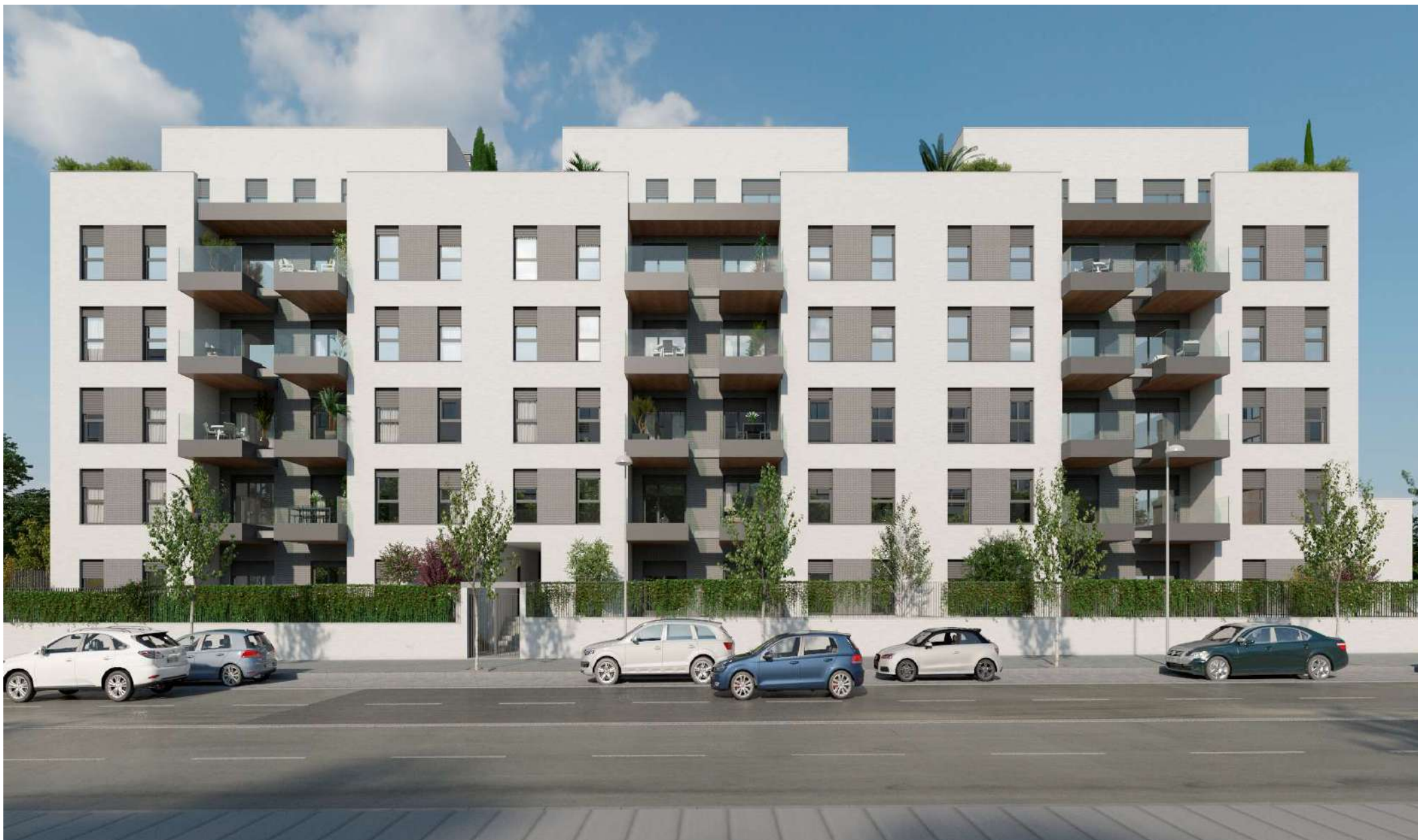
FACHADA EXTERIOR ESTE (Vía Pública)
