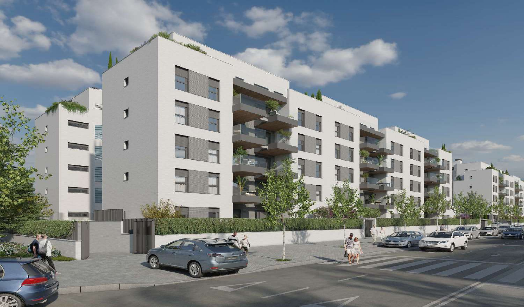
FACHADA EXTERIOR SURESTE (Entrada Vehículos Garaje Subterráneo) ——— 8
