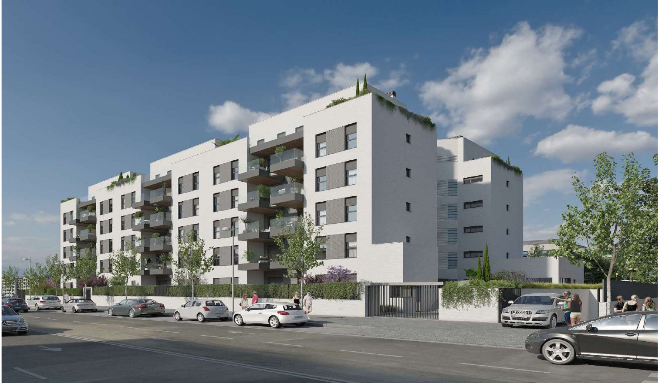
FACHADA EXTERIOR NORESTE (Acceso Peatonal-Salida Vehículos Garaje Subterráneo) — 7
