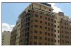
EL ENCINAR DE VALDEBEBAS, S. COOP. MAD. (VPPB). Valdebebas (Madrid). Entregada: 2014. 73 viviendas de 2 y 3 dormitorios. Urbanización con piscina, pádel, jardines, zona infantil, sala comunitaria y conserjería.
