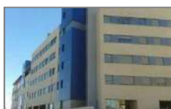
VIVENCIA VALDEBEBAS, S. COOP. MAD. (VPPL). Valdebebas (Madrid). Entregada: 2014. 40 viviendas de 2, 3 y 4 dormitorios. Urbanización con piscina, jardines, zona infantil, sala comunitaria y conserjería.
