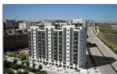
MIRADOR PARQUE VALDEBEBAS 2016, S. COOP. MAD. (VPPL). Valdebebas (Madrid). Entregada 2020. 60 viviendas de 2, 3 y 4 dormitorios. Urbanización con piscina, jardines, zona infantil, sala comunitaria y conserjería.
