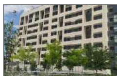
EL CAMPUS DE VALDEBEBAS, S. COOP. MAD. (VPPB). Valdebebas (Madrid). Entregada: 2014. 74 viviendas de 2 y 3 dormitorios. Urbanización con piscina, pádel, jardines, zona infantil, sala comunitaria y conserjería.
