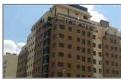
EL ENCINAR DE VALDEBEBAS, S. COOP. MAD. (VPPB). Valdebebas (Madrid). Entregada: 2014. 73 viviendas de 2 y 3 dormitorios. Urbanización con piscina, pádel, jardines, zona infantil, sala comunitaria y conserjería.
